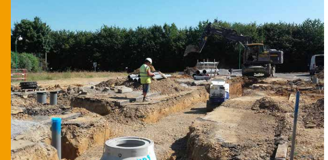
Rue Mme Gandin : Travaux de viabilisation
